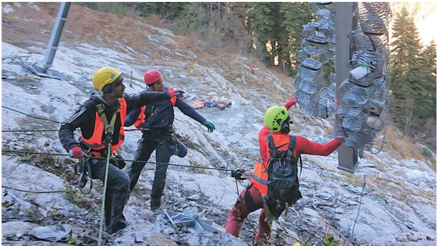
Heli-Montage der Lawinerverbauung TS-LV aus Salzburg im russischen Kaukasus Gebirge.
